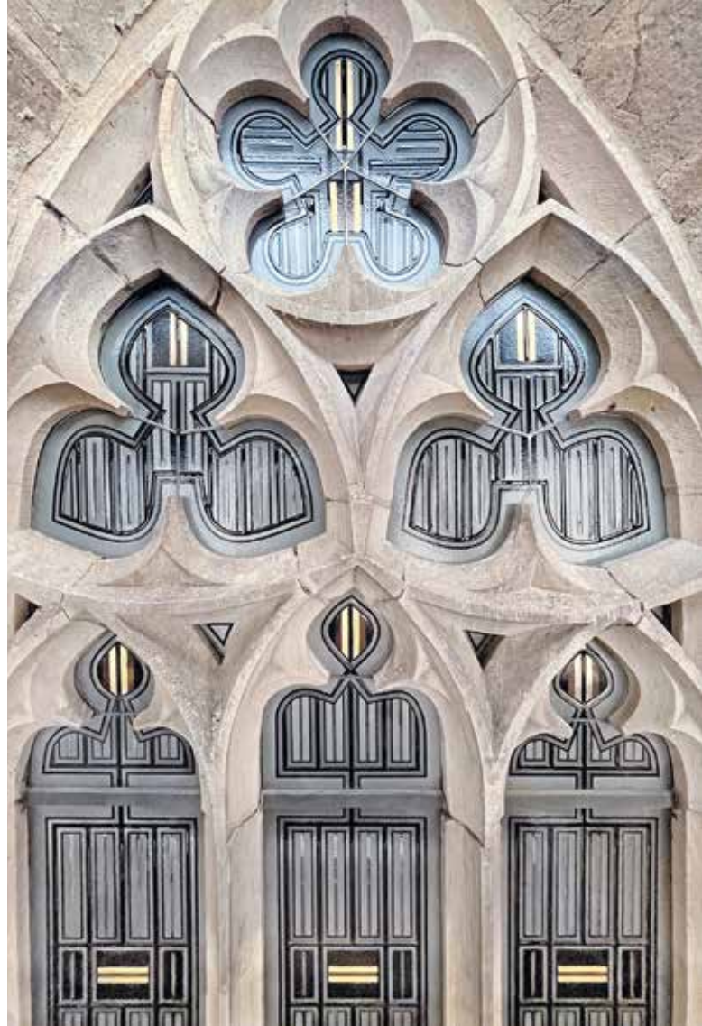
Die neuen Fenster der Wallonerkirche wirken zeitlos-modern und zugleich traditionsbewusst.
